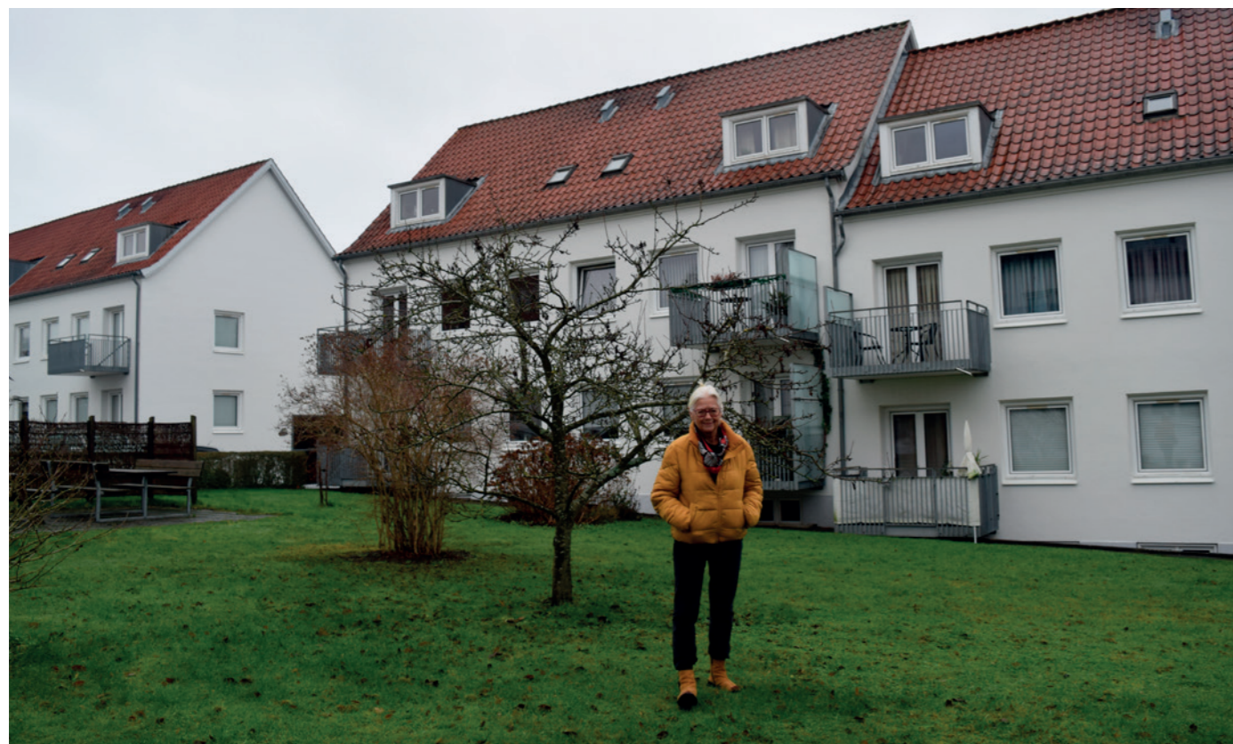
På grund af det skrånende terræn er de to sydlige blokke opført i to planer, forskudt på midten.
