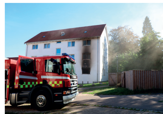
Voldsom brand hærger en hel blok på Pontoppidansvej.
